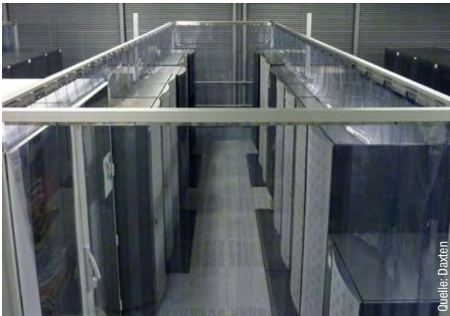
Beispiel für eine weiche Einhausung eines Kaltgangs bei Racks mit unterschiedlichen Höhen und Stelltiefen (Abb. 1).
