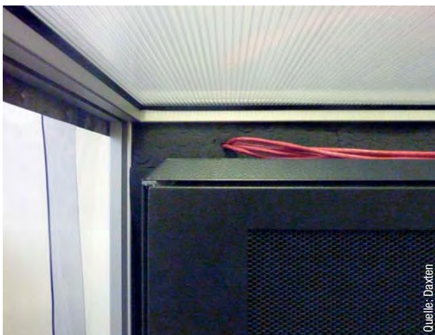
Das Aluminiumprofil für die hybride Einhausung nimmt sowohl Kunststoffvorhänge als auch solide Paneele auf (Abb. 3).
