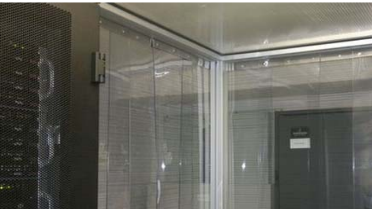
Daxten CoolControl Einhausungslösung aus Vorhängen und festen Dachpaneelen
