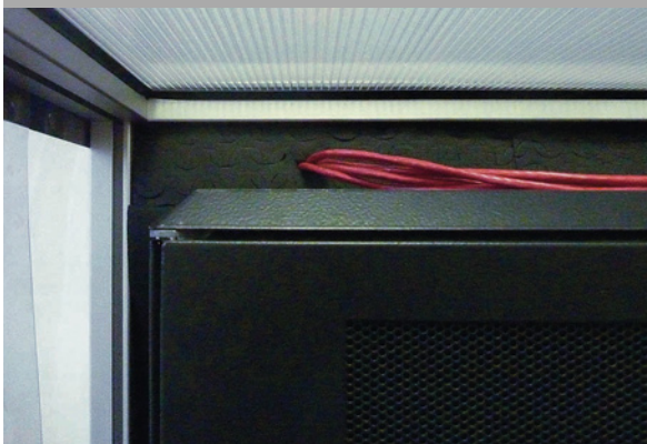
Das Aluminiumprofil für die Einhausung nimmt sowohl Kunststoffvorhänge als auch solide Paneele auf.
